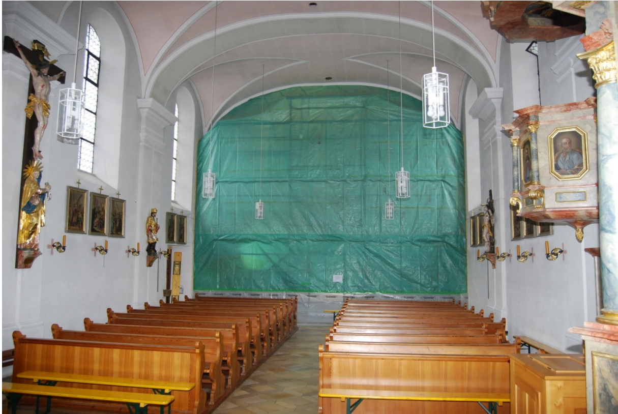
Die Pfarrkirche mit der Staubschutzwand
