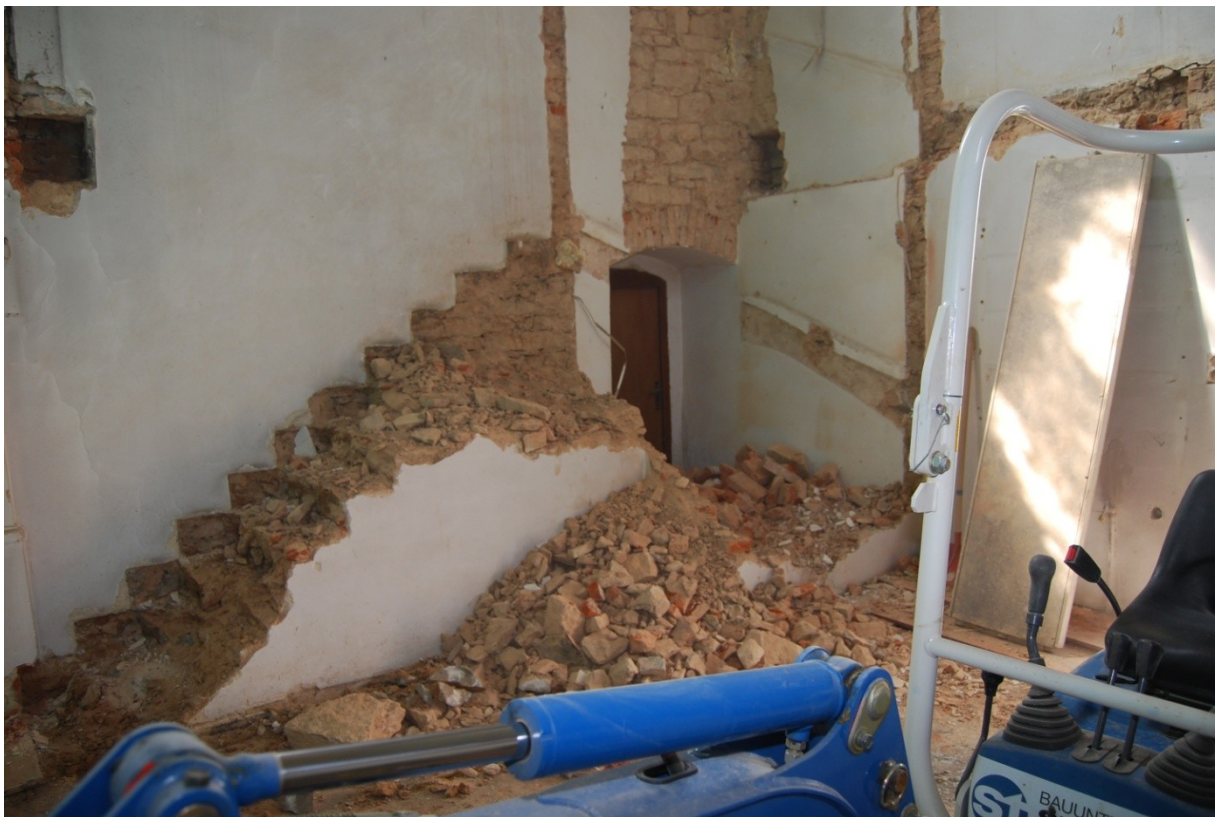
Der Umbau war kurz und beschwerlich.
