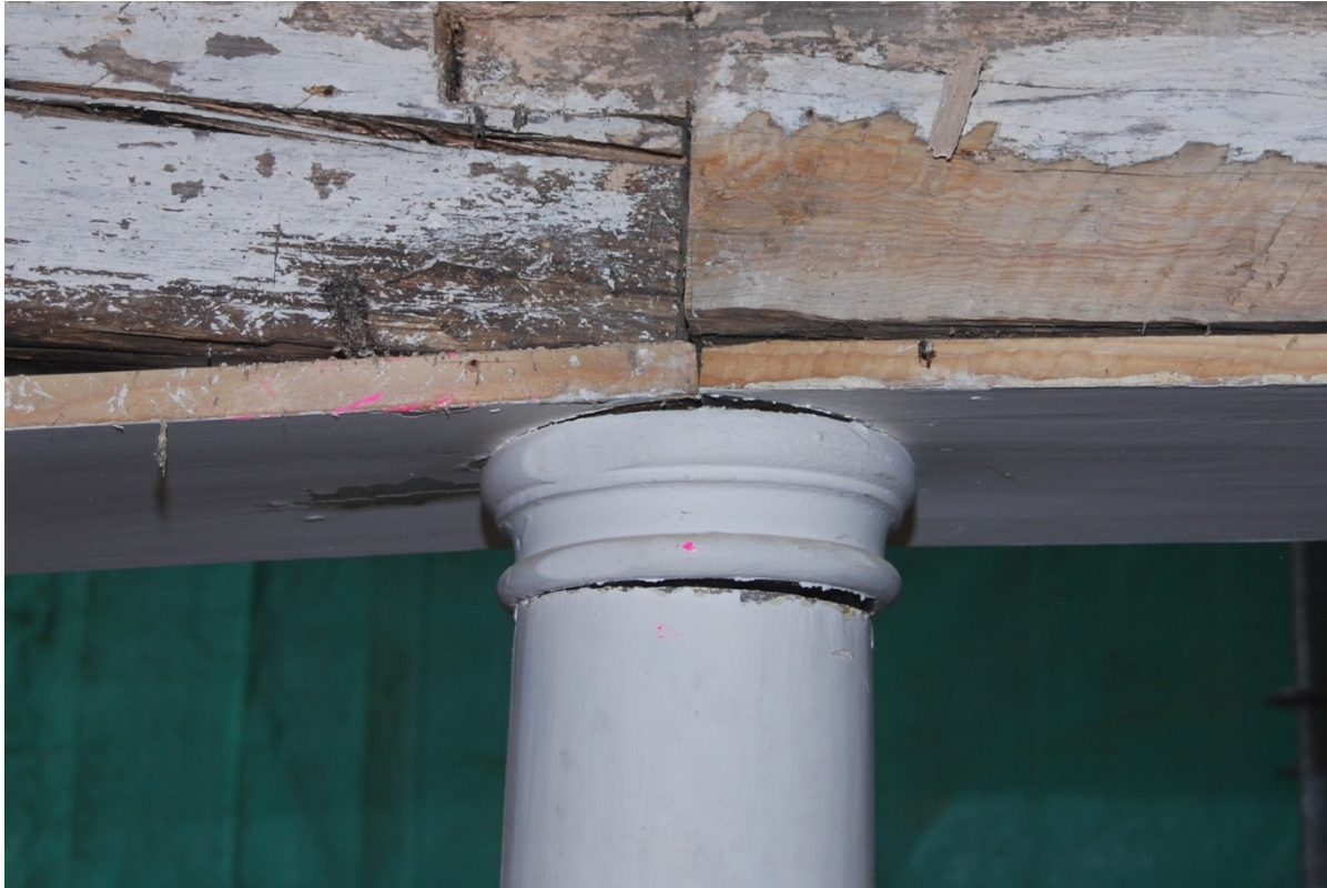
Die Stützen der alten Empore waren nur lose hineingestellt!
