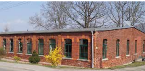
Ehemaliges Webereigebäude in Limbach wird zur neuen Werkstätte des Orgelbaubetriebs von Thomas Wolf.
